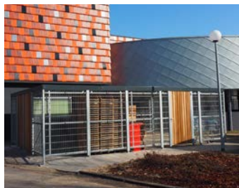
Zijwanden van traliepanelen, deuren van hout
