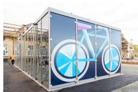
Wanden bekleed met Trespa beplating en bestickerd met graphics
