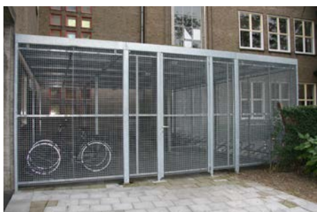
Wanden bekleed met persrooster
