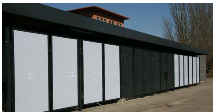
Wanden bekleed met opaal polycarbonaat, deuren met perfolaat gepoedercoat in RAL
