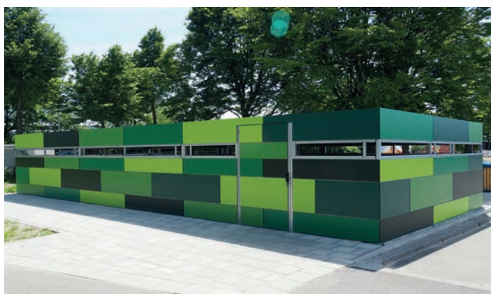
Wanden bekleed met Trespa beplating in wildverband
