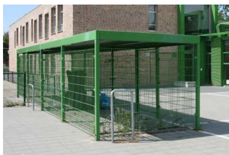
Staalconstructie en traliewanden gepoedercoat
