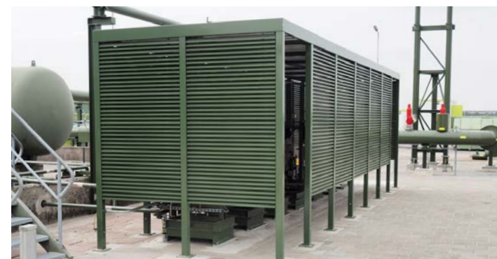
Wanden bekleed met Storax lamellen type ST-050 HF, gepoedercoat in RAL
